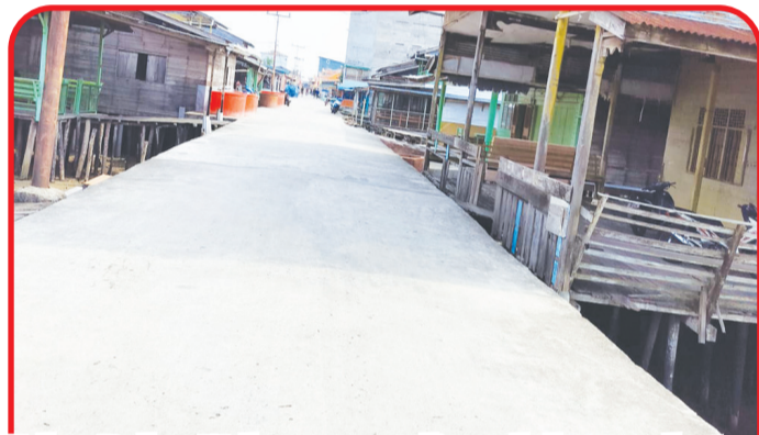
Jalan Pulau Halang yang diaspal dengan beton semen.
